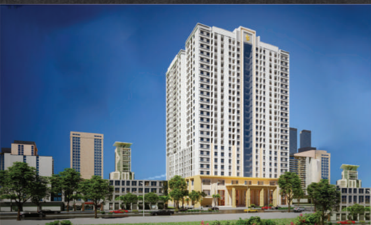
9. DỰ ÁN: TÒA NHÀ PHOENIX TOWER BẮC NINH ĐỊA CHỈ: VÒNG XOAY NGÃ 6 LÝ THÁI TỔ, BẮC NINH
